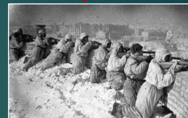
На крыше дома
